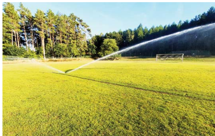
Im Zuge des Projektes „autarker Sportplatz“, erfolgt die Beregnung der Plätze jetzt automatisch
